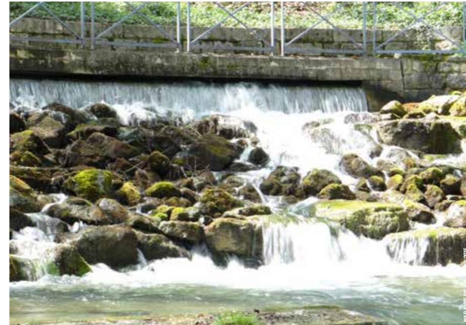
— Canaux et vannes permettaient de maîtriser le débit des eaux
